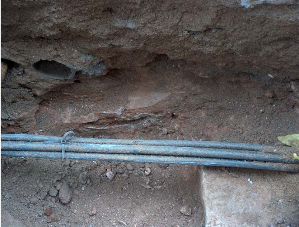
Foto 3: U.E. 303. Mur de dipòsit
