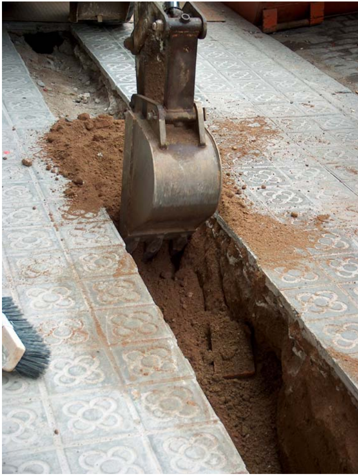
Foto 7: Obertura de la rasa a màquina.
